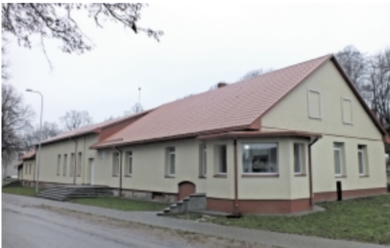
Piktupėnų kultūros centras po rekonstrukcijos.
