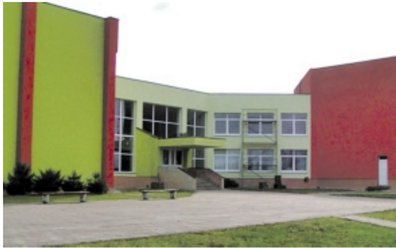
Šilutės žemės ūkio mokyklos katilinėje prieš pustučių metų buvo įvykdytas nusikaltimas, byla baigta nagrinėti tik dabar.
