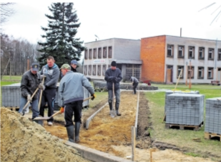
Usėniškiai, gavę 20 tūkst. litų paramą infrastruktūros sutvarkymui, jau pradėjo darbus – šiuolaikiškais trinkelėmis klojamas šaligatvis.
