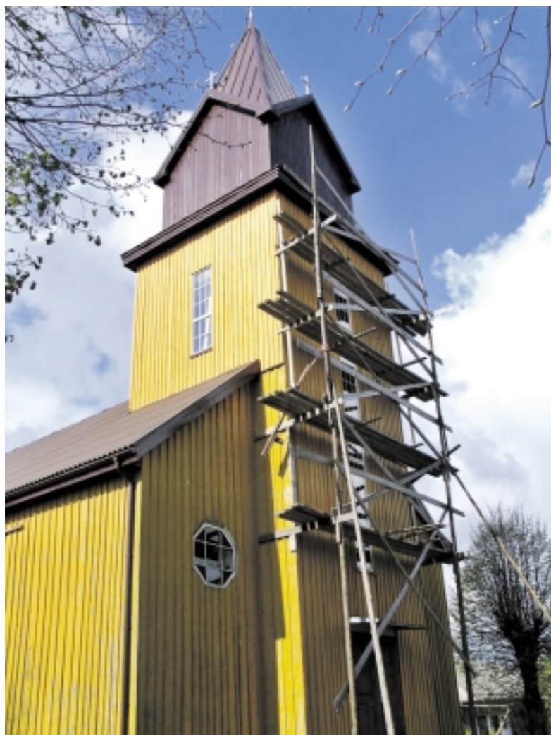
Naujas stogas ant bažnyčios atsirado padedant UAB „LL investicijos“.
