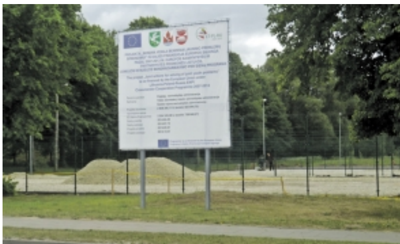
Šalia būsimąjo aikštyno pastatytas informacinis stendas, statybos darbai jau prasidėjo.
