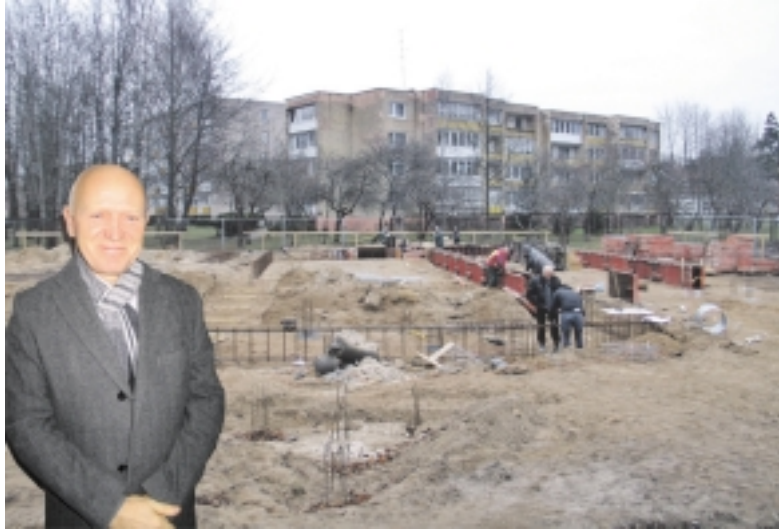
Prie pamatų ketvirtadienį darbuojasi nemažas būrys UAB „Žibai“ statybininkų. Darbams vadovauja patyręs vadovas S. Kazlauskas.
