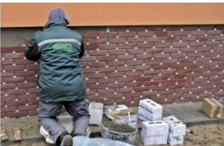
UAB „Šilo statyba“ darbininkai gražiomis plytelėmis apdailina Gluosnių gatvės 7-ojo namo pamatus.
