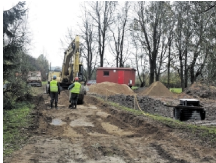
Vykdomi statybos darbai Žemaitkiemyje.
