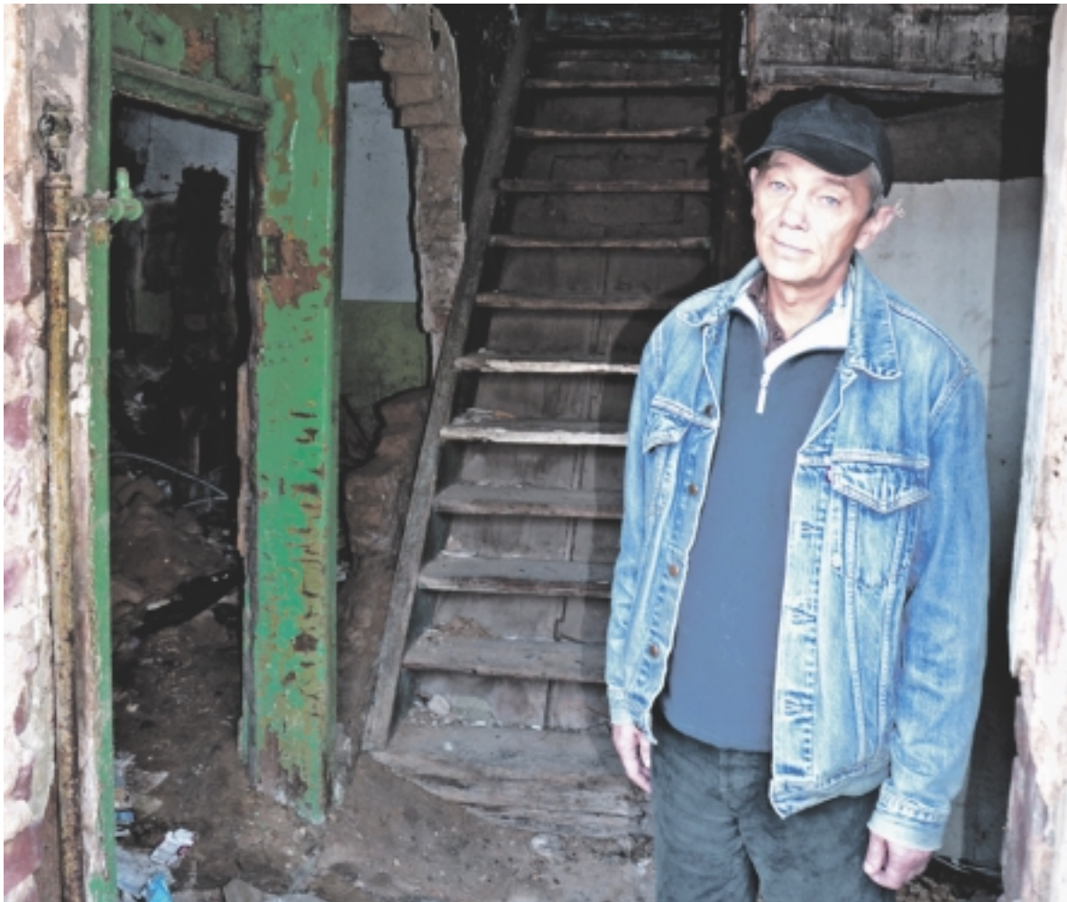
P. Jokšas išgyvena nerimo dienas – nežinia, ar nugriovus jo namą jis turės apsigyventi tiesiog gatvėje...
