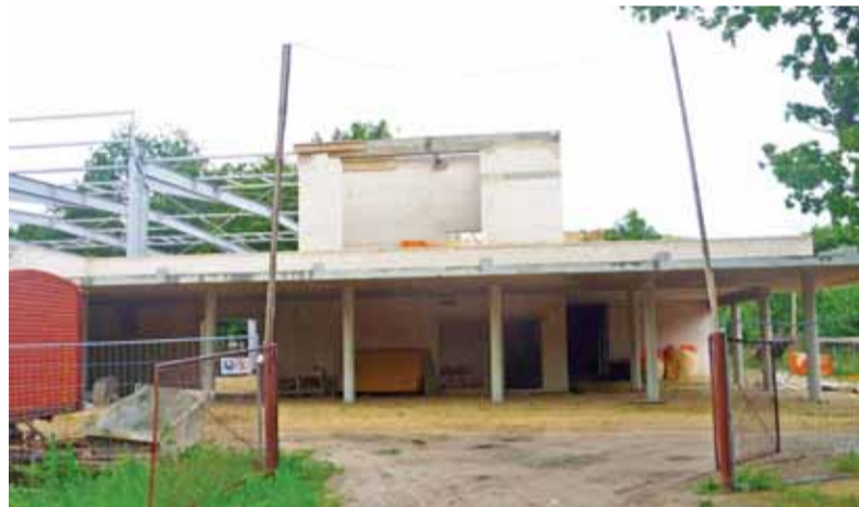
Jau ryškėja būsimosios sporto salės kontūrai.
