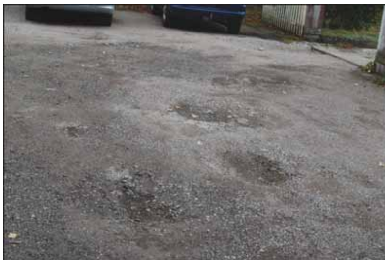
Kai kurios duobės buvo užpildytos frezuotu asfaltu... Bet naudos iš to mažai.
