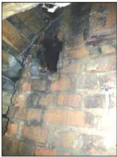
Šis kaminas - apgriuves, pro jį veržiasi dūmai. Šį kamina ir bando rasti „Šilutės būstas“.
